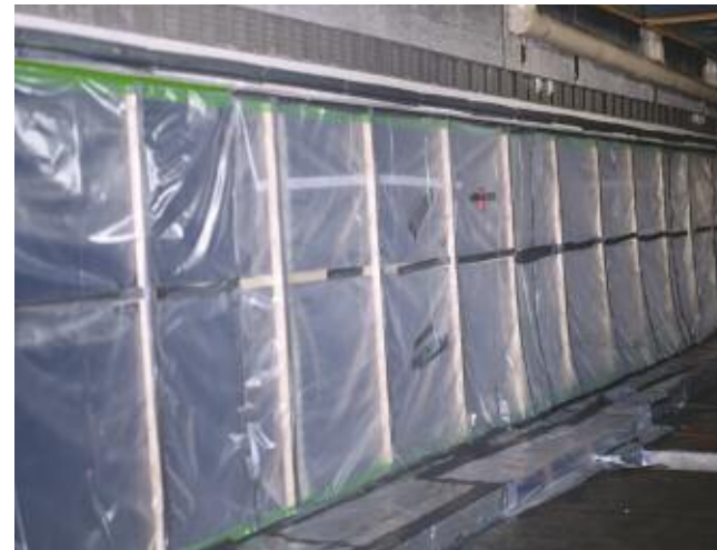
Luftdichte Abschottung - Trennung zwischen Schwarzbereich und Weißbereich.
