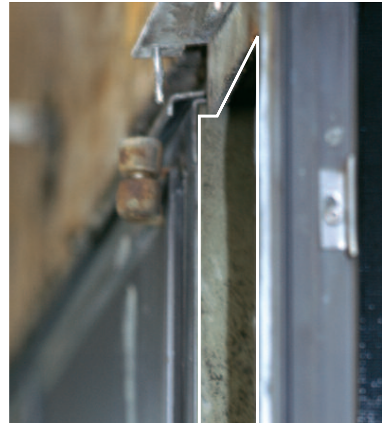
Bei dem markierten Bereich handelt es sich um die Spritzasbest-Ummantelung einer Stahlbaustütze (vor dem Abbruch).
