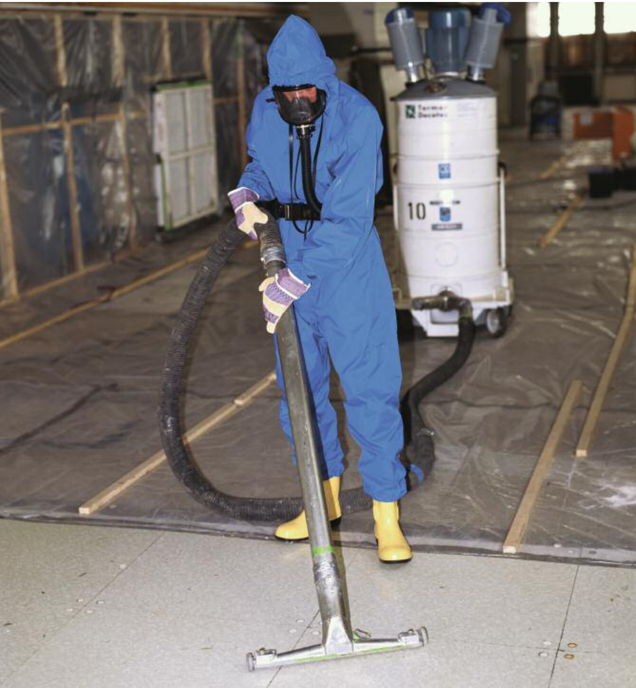
Nach Abschluss der Asbestentsorgung ist eine Feinreinigung aller Flächen im Schwarzbereich vorzunehmen.
