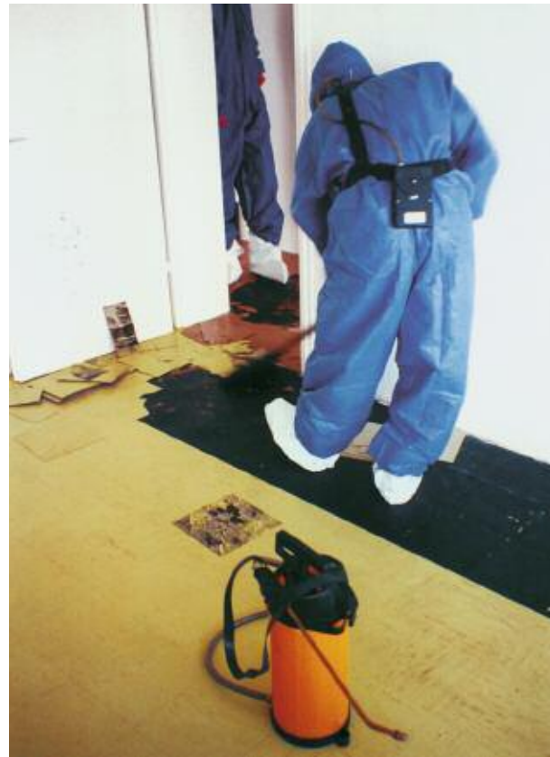
Entfernen von Flexplatten.
